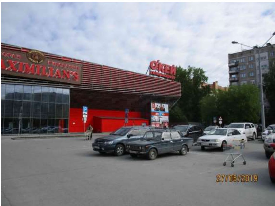
Фото № 3. Нежилое здание с кадастровым номером 54:35:032600:120
