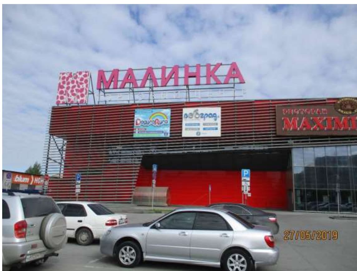
Фото № 1. Нежилое здание с кадастровым номером 54:35:032600:120
