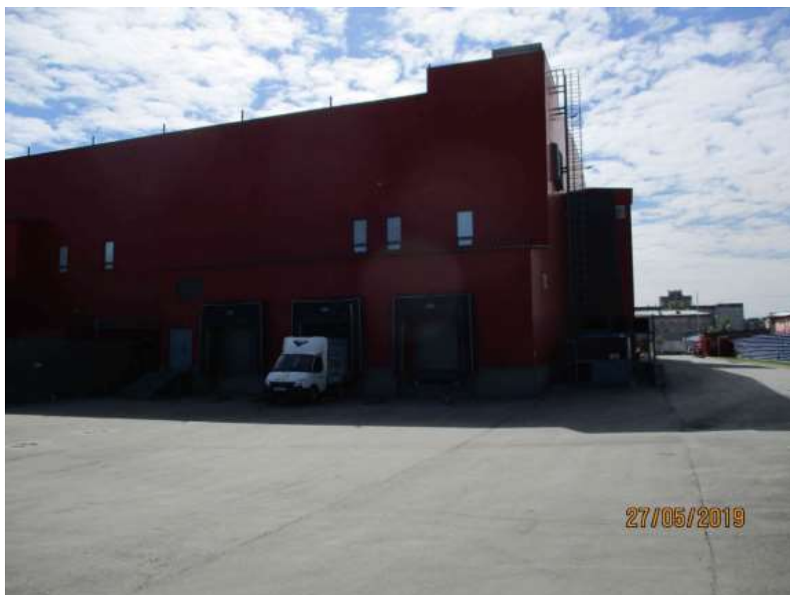
Фото № 5. Нежилое здание с кадастровым номером 54:35:032600:120
