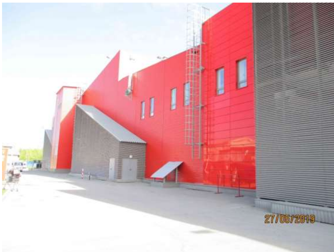
Фото № 4. Нежилое здание с кадастровым номером 54:35:032600:120
