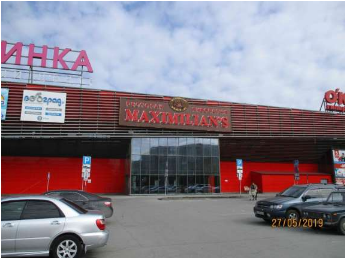
Фото № 2. Нежилое здание с кадастровым номером 54:35:032600:120
